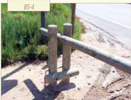
Barrière d'accès en bois
