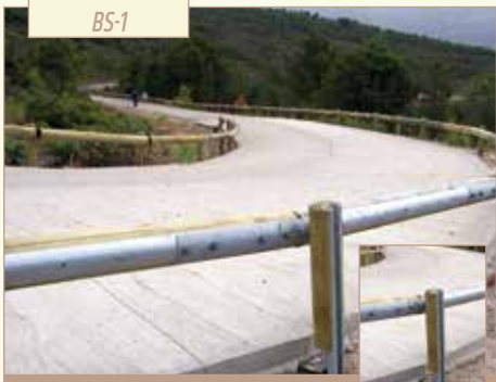
Barrière de sécurité pour les routes
