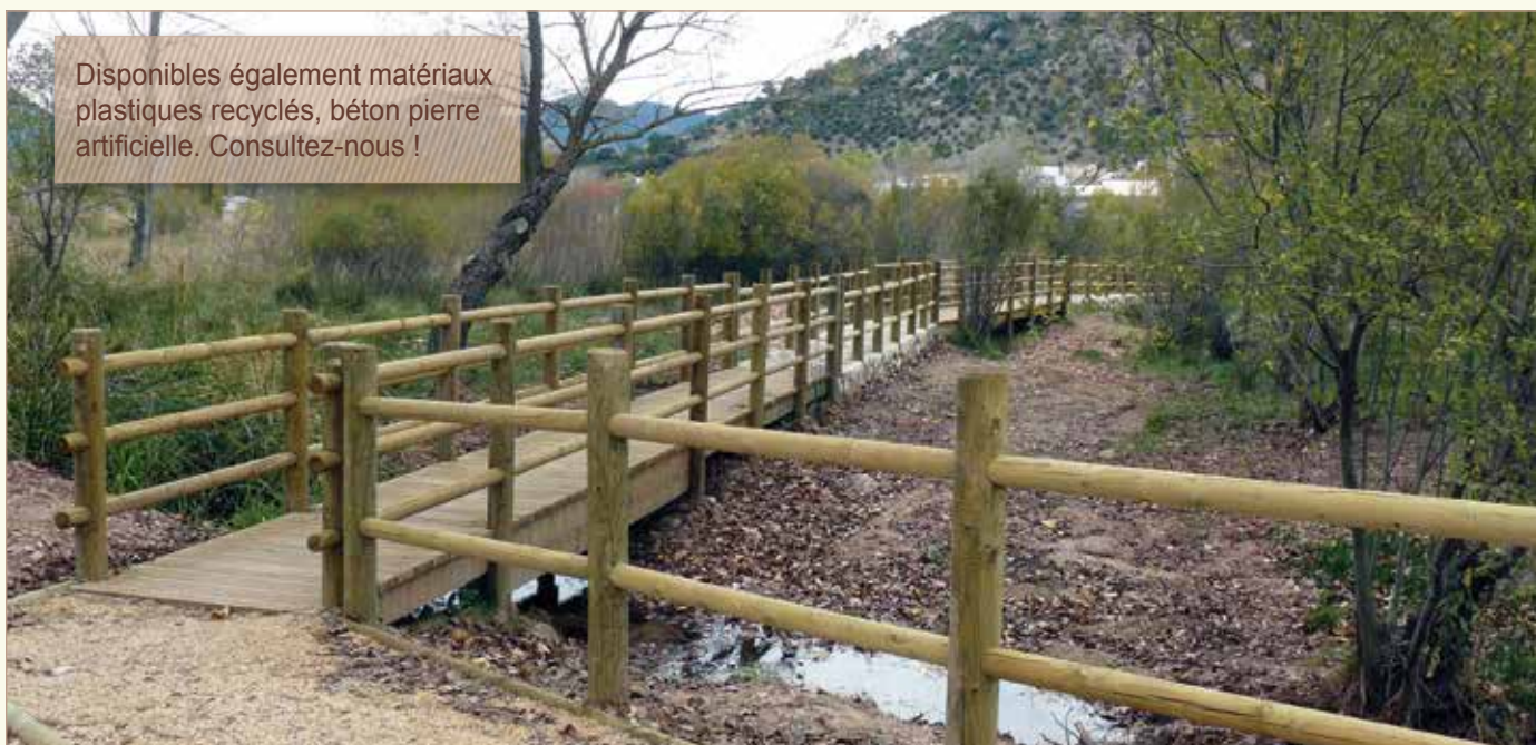
Passerelle piétonne élevée Riópar (Albacete)
