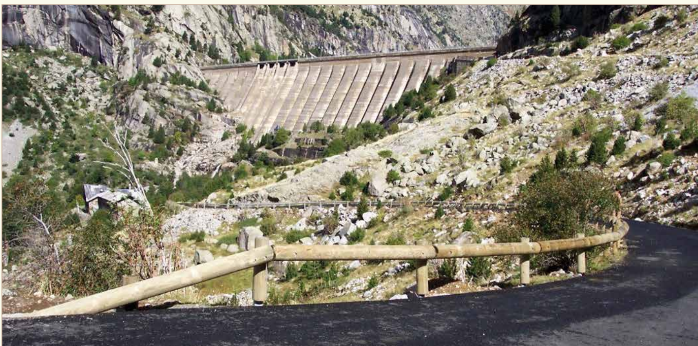
Barrière de sécurité pour les routes Cabezón de la Sal (Cantabria)
